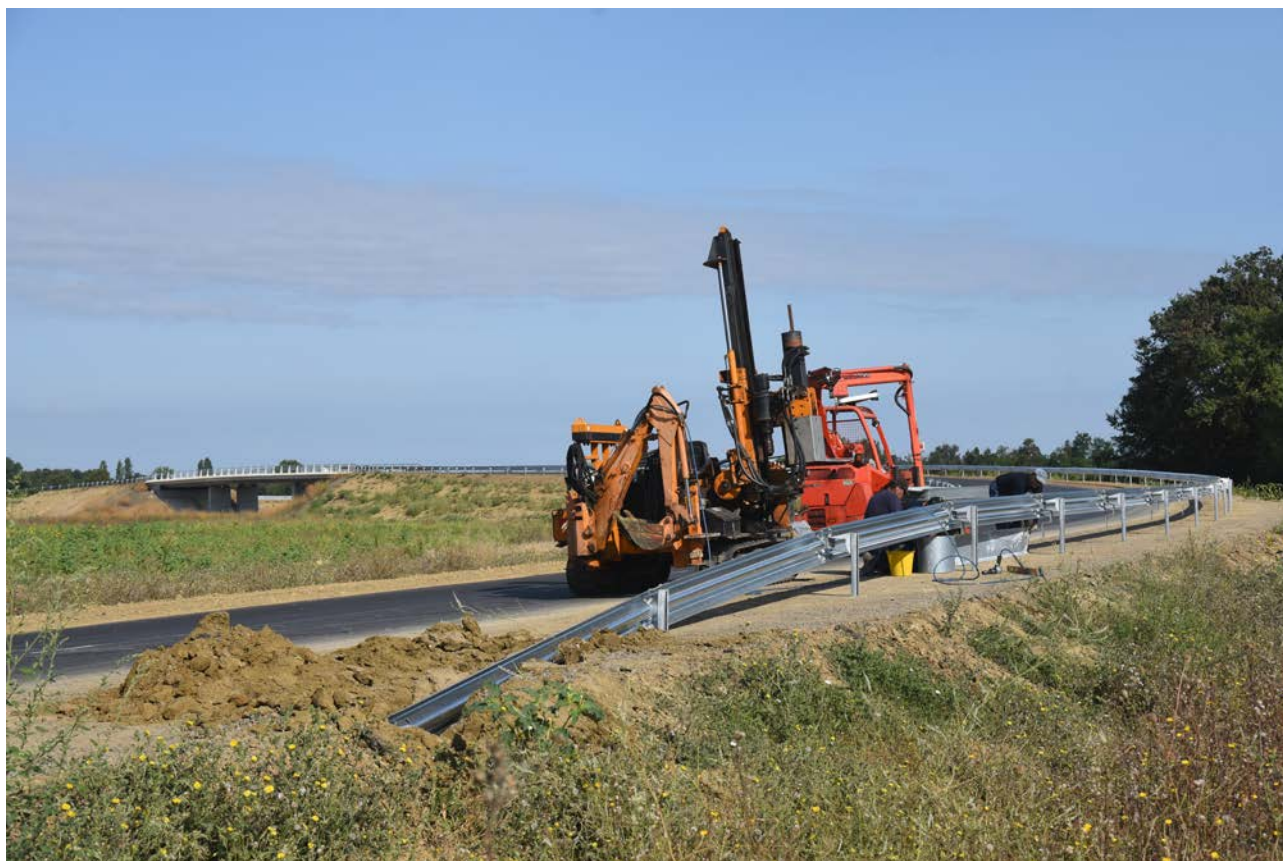
Pose des équipements de sécurité par les agents du Département.
